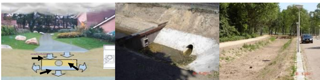
Figure 5-2 Links wadi-principe, midden: zuiverende stuw, rechts wadi net na aanleg in Doornakkers
