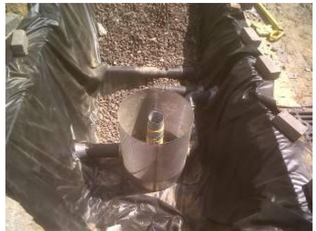
Figuur 25 Infiltratieput met diverse aansluitingen. De verticale buis in de linkerfoto (rechterkant) is voor de monstername en komt uit in het trottoir. De horizontale buis in de rechterfoto (bovenkant) is een huisaansluiting. Het HDPE folie is hier overeen geplaatst waardoor deze als drempel in de voorziening functioneert. Hierdoor staat de infiltratieput nu in een bakje waar altijd een laag water in zal staan.
