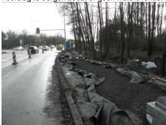
Figure 4-1 foto van aanleg lavafilter te Rotterdam
