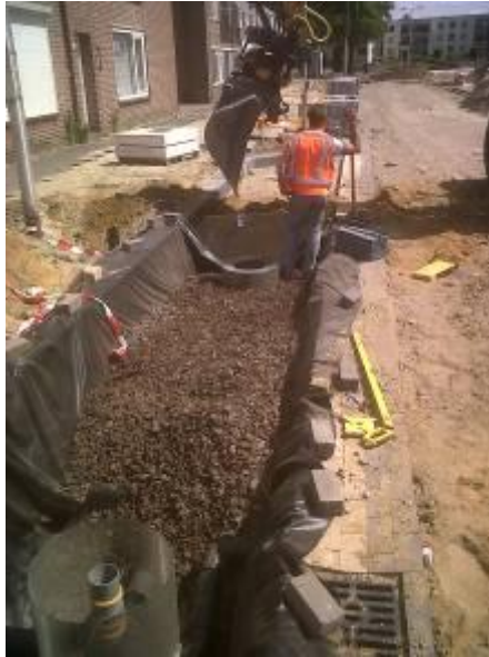
Figuur 24 Overzicht van de voorziening bij aanleg. Infiltratieput aan onderzijde, drainageput aan bovenzijde.
