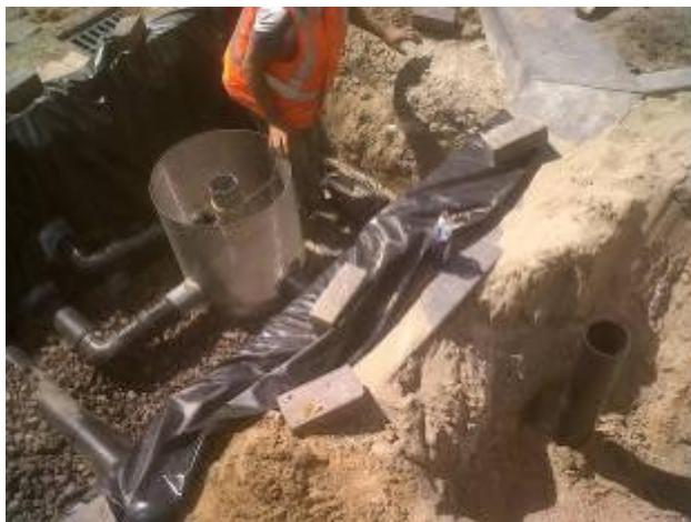
Figuur 25 Infiltratieput met diverse aansluitingen. De verticale buis in de linkerfoto (rechterkant) is voor de monstername en komt uit in het trottoir. De horizontale buis in de rechterfoto (bovenkant) is een huisaansluiting. Het HDPE folie is hier overeen geplaatst waardoor deze als drempel in de voorziening functioneert. Hierdoor staat de infiltratieput nu in een bakje waar altijd een laag water in zal staan.
