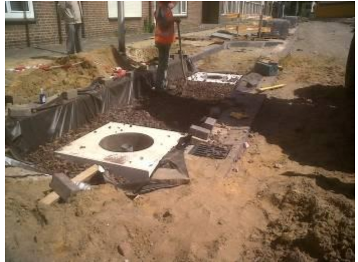
Figuur 24 Overzicht van de voorziening bij aanleg. Infiltratieput aan onderzijde, drainageput aan bovenzijde.
