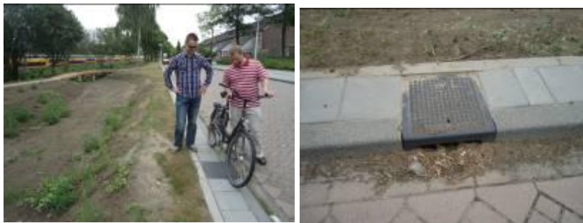
Figure 5-7 kolken naast watersysteem
